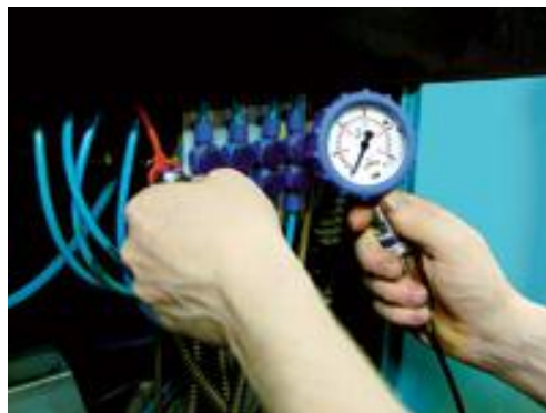
検圧作業（イメージ）
